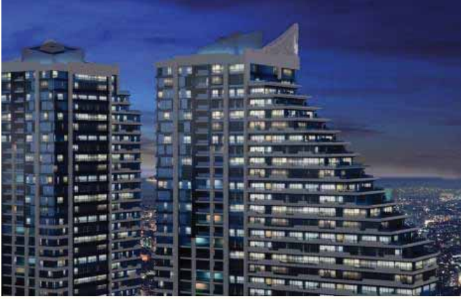
Şekil46.Fikirtepe Evim Kadıköy-yapım aşamasında
