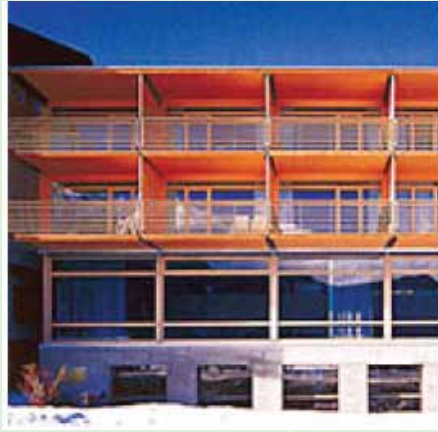
Şekil 9: Post Otel Binası (avusturya) endüstriyel yapım yöntemleri syf688
