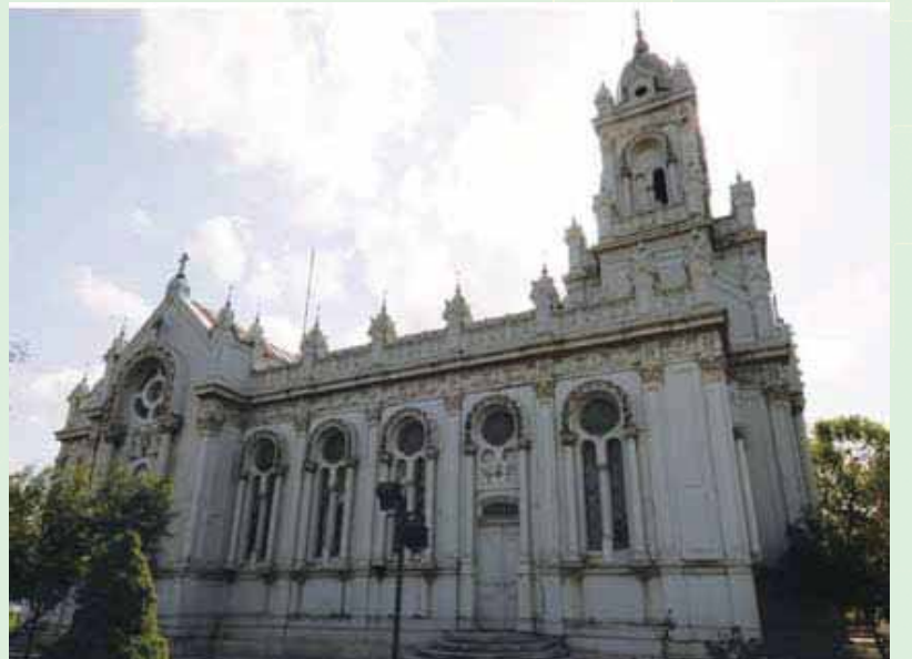
Şekil 10: Sveti Stefan Kilisesi beton prefabrikasyon incelemesi 2009 syf16
