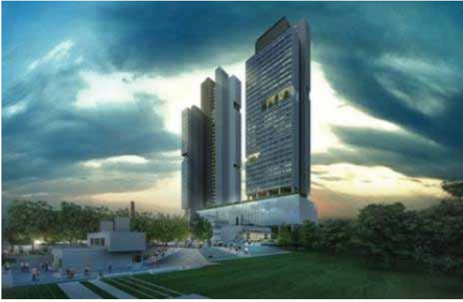
Şekil45.Eskikör fabrikasıM.köyQuasar-yapım aşamasında
